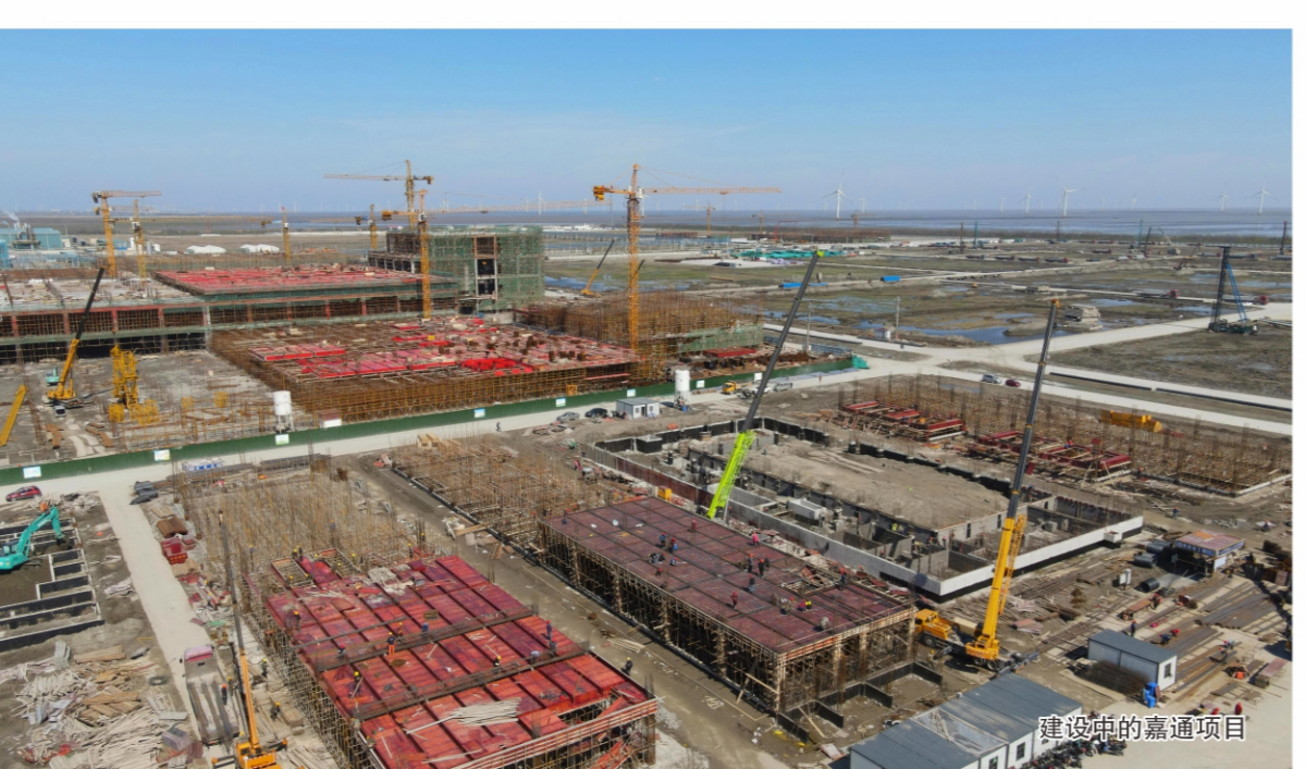
嘉通项目施工现场
