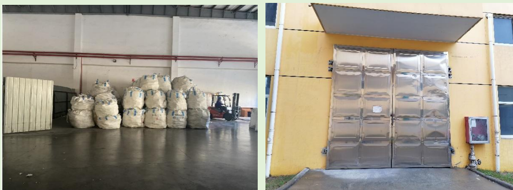
图 3.3-6 一般废物堆场照片（内部照片、外部照片）
