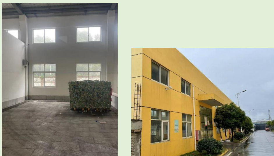
图 3.3-5 危废暂存库照片（摄像头安装照片）
