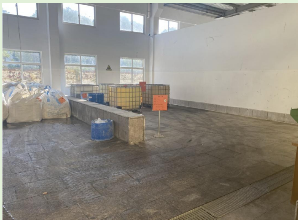
图 4.2-1 危废暂存库照片（内部照片）
