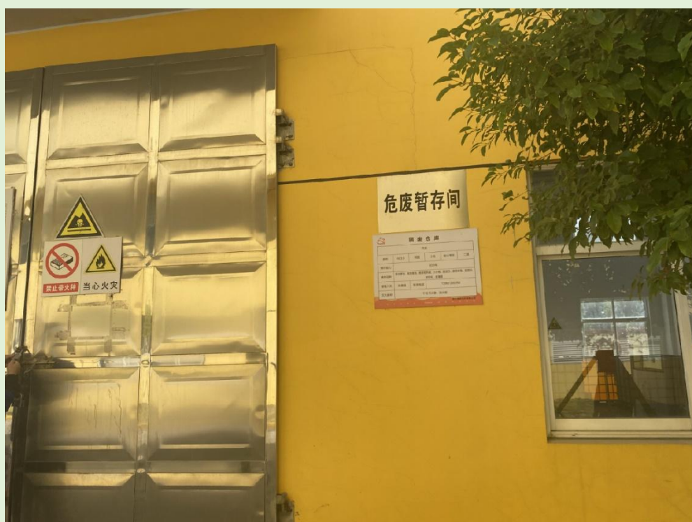
图 4.2-2 危废暂存库照片（外部照片）
